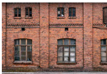
Revêtement de brique
