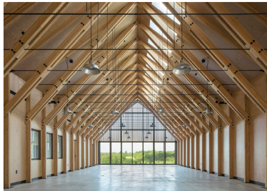
Figure 3 Le Centre de découverte des abeilles et pollinisateurs Tasjian conçu par MSR Design frames est un exemple de bâtiment avec des connecteurs exposés (Source : AIA, 2020; Crédit photo : Richard Brine)
